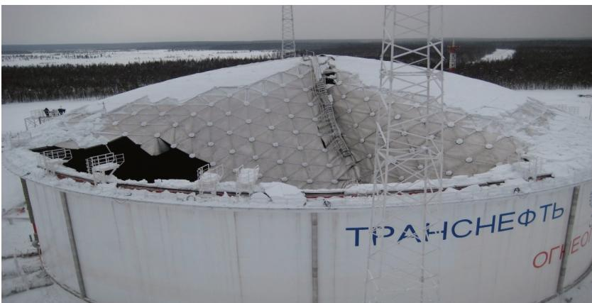
Рисунок 1.8 – Лавинное разрушение купольной крыши РВСПА-50000
