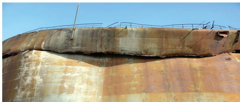
Рисунок 1.10 – Повреждение в результате коррозии и вакуума в резервуаре
