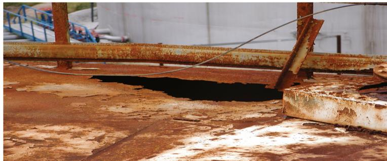
Рисунок 1.9 – Сквозная коррозия настила стальной крыши резервуара
