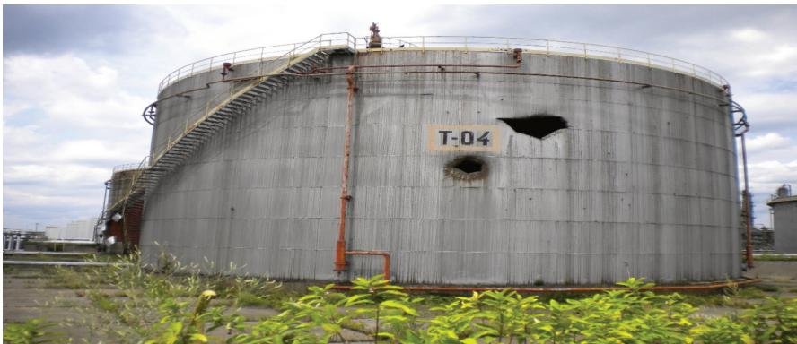
Рисунок 1.13 – Повреждения стенки резервуара в результате прилета снарядов
