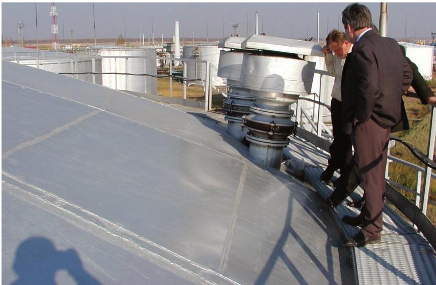
Рисунок 9.1 – Купольная крыша из алюминиевых сплавов после 25 лет эксплуатации
