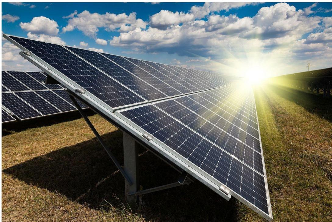
Солнечные панели покрывают антибликовым слоем, чтобы солнечная энергия не отражалась от поверхности панели, а поглощалась ей. А для защиты данной конструкции от дождя на её поверхности устанавливают стекло.
