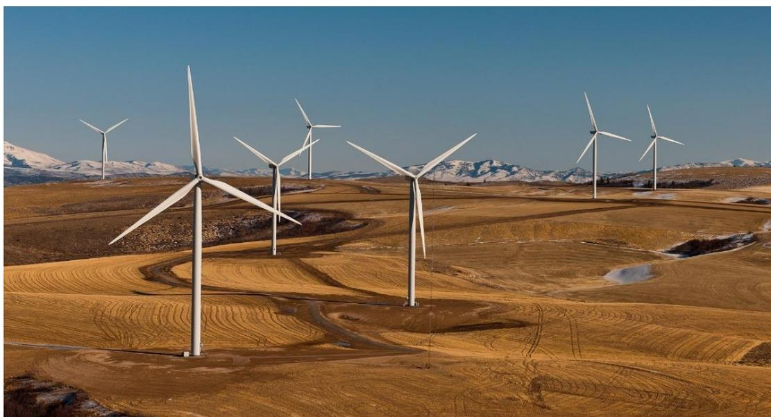
Из-за ветра лопасти мельницы начинают вращаться, а вращательное движение мельницы уже преобразовывается в электроэнергию.
