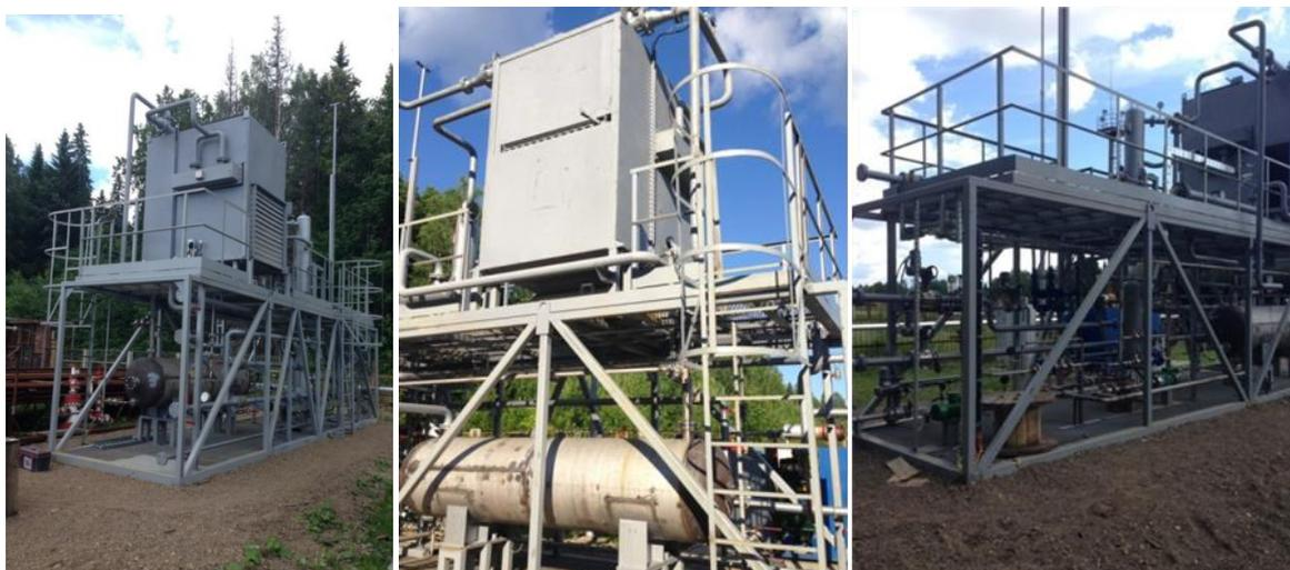
Рис. 1 – Блок сероочистки
