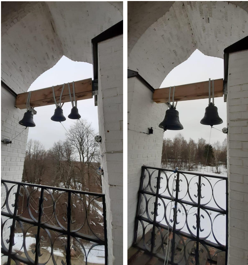
Рисунок 12. Отлитые колокола уставлены на храм с электронным звонарем в октябре 2018 г. Храм Игнатия Богоносца в Путогино.
