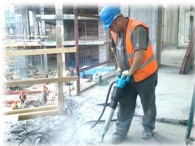
Работа пневматического бетонолома Б-3 КНР: 14,9 кг, 100 Дж, 13 с -1 , 1300 Вт, 1,5 м 3 /мин/кВт
