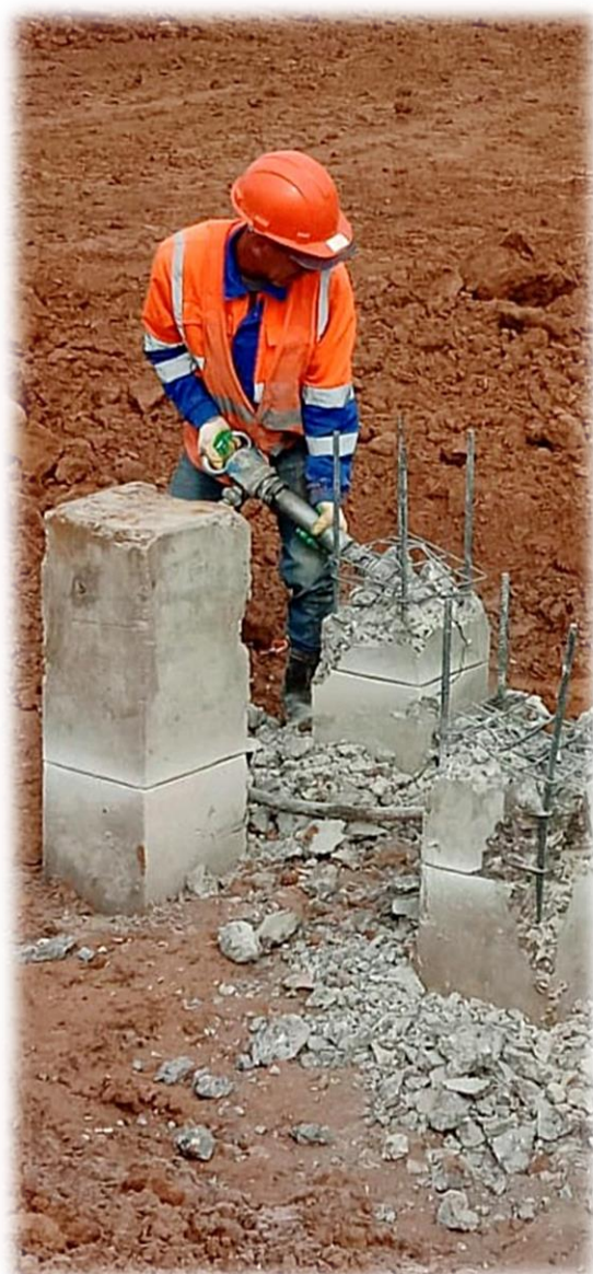
Работа молотка МОР-3 ТЗК по бетону 7,8 кг, 44 Дж, 20,5 с -1 , 900 Вт
