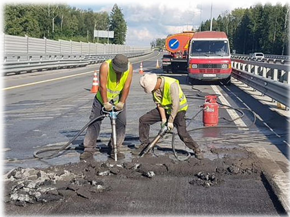
Дорожные работы: молотки МО-4Б ТЭМЗ и МОП-3 ТЭК
