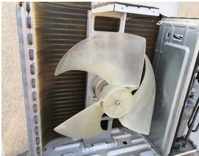
Рис. 3.3. Конденсатор наружного блока
