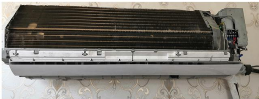
Рис. 3.1. Испаритель прямого испарения
