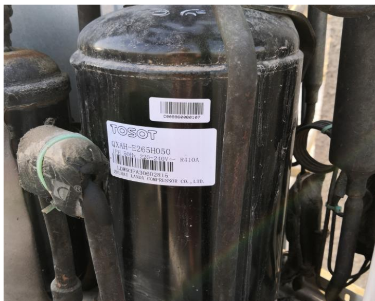
Рис. 3.2. Роторный компрессор
