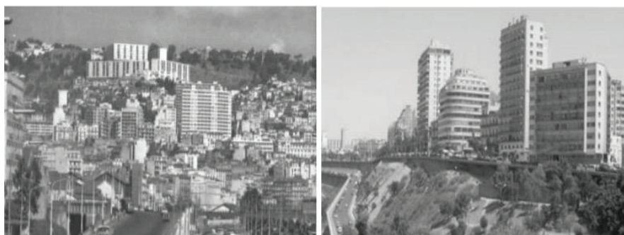
Рисунок 3.2 – Конструктивные решения жилых домов многоэтажной застройки городов на территории Северного Алжира
